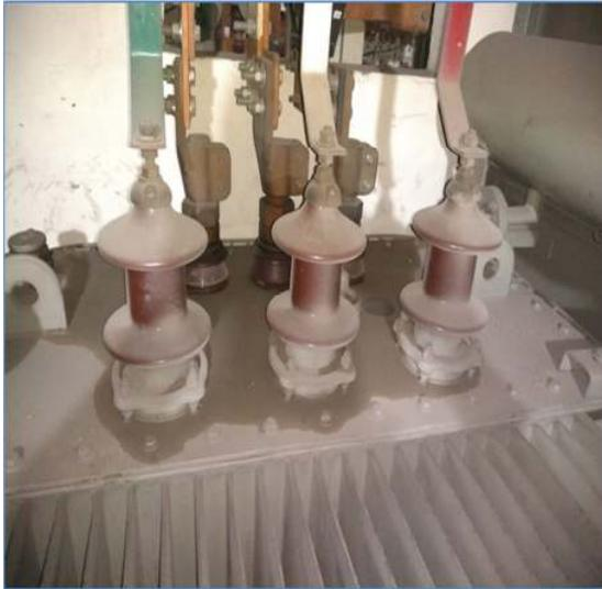
**FUGA DE ACEITE EN EL TRANSFORMADOR, MAL ESTADO DE LAS EMPAQUETADURAS**
